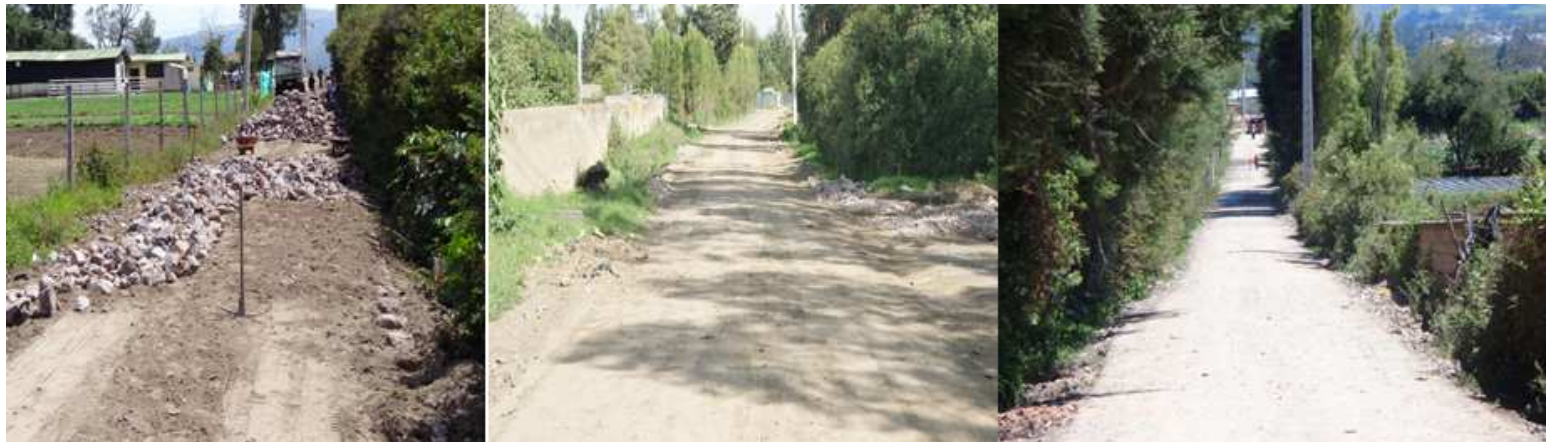
TRABAJOS EN EJECUCIÓN
